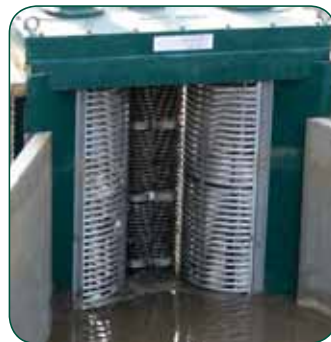
Giriř yapısına monte edilmiř CDD6020-XDM2.5 modeli.
